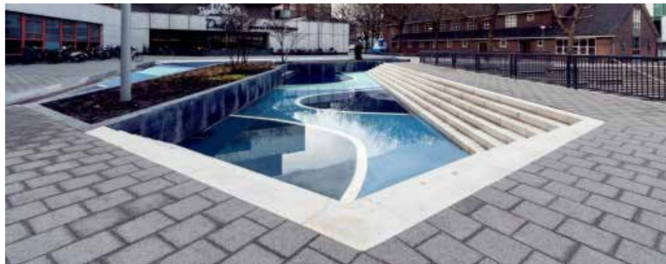
Waterplein Bentheplein, Rotterdam
